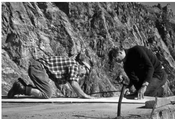
1972: riparazione dei danni subiti dal tetto.
