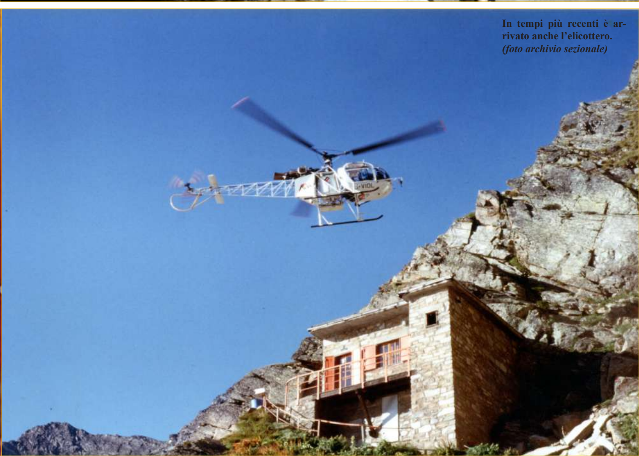
1972: lavori di ripristino del tetto. (foto archivio Mario Merlo)
