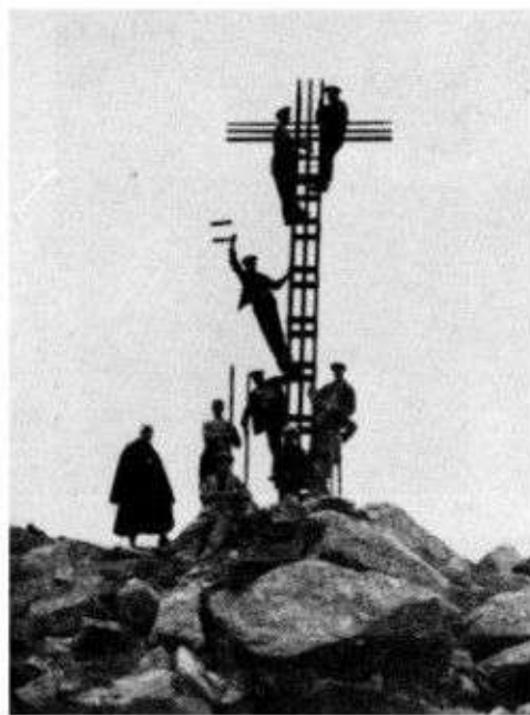
Montaggio della croce
